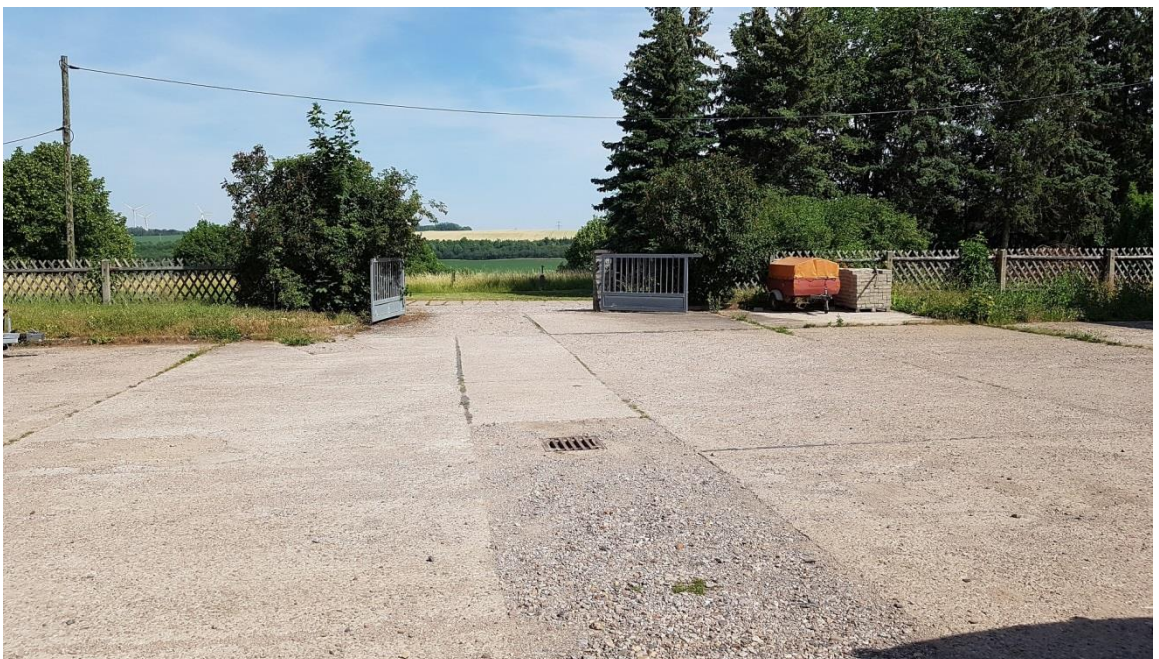
Hoffläche mit Zufahrt
